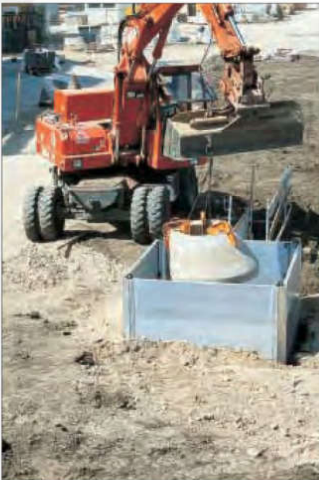
Bagger hebt einen Schachtring
