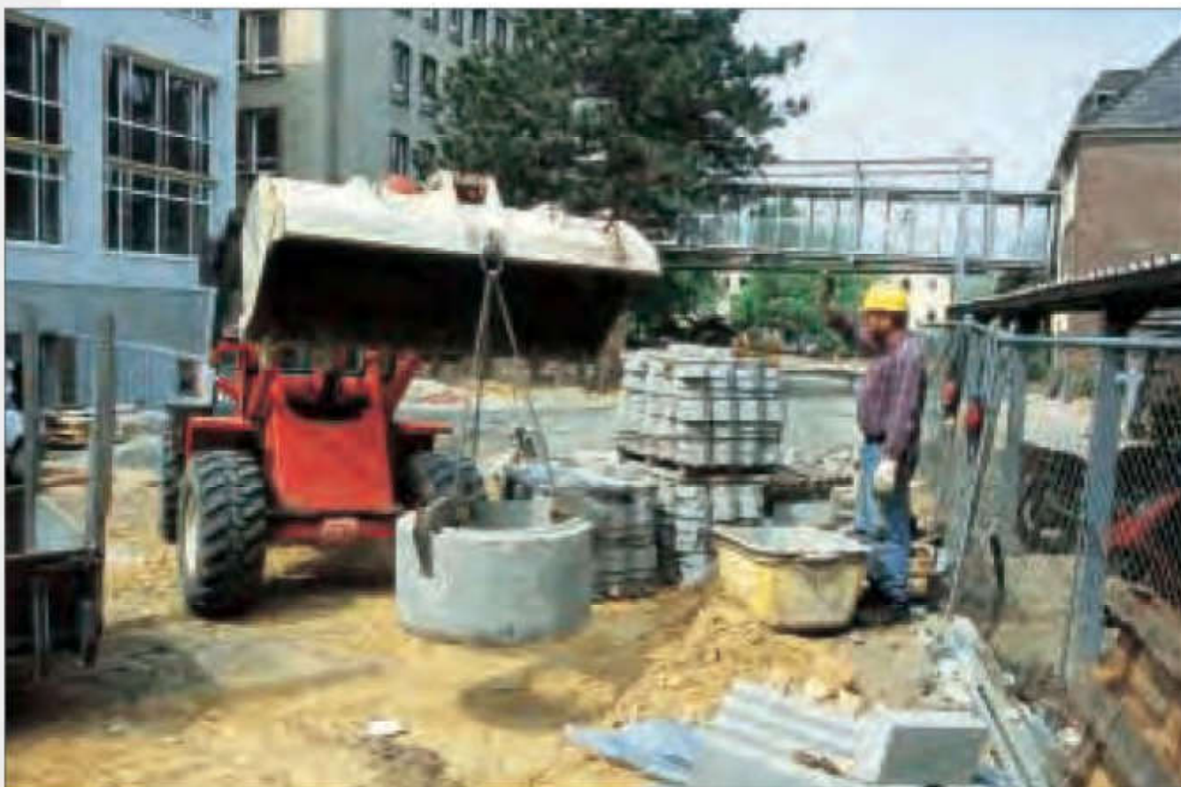
Der Radlader fährt rückwärts, die Last befindet sich nahe über dem Fahrweg
