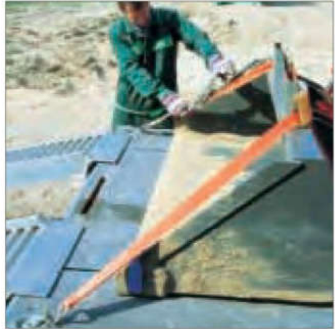
Sichern der Ladung mit Zurrpunkt, Zurrgurt und Kantenschoner
