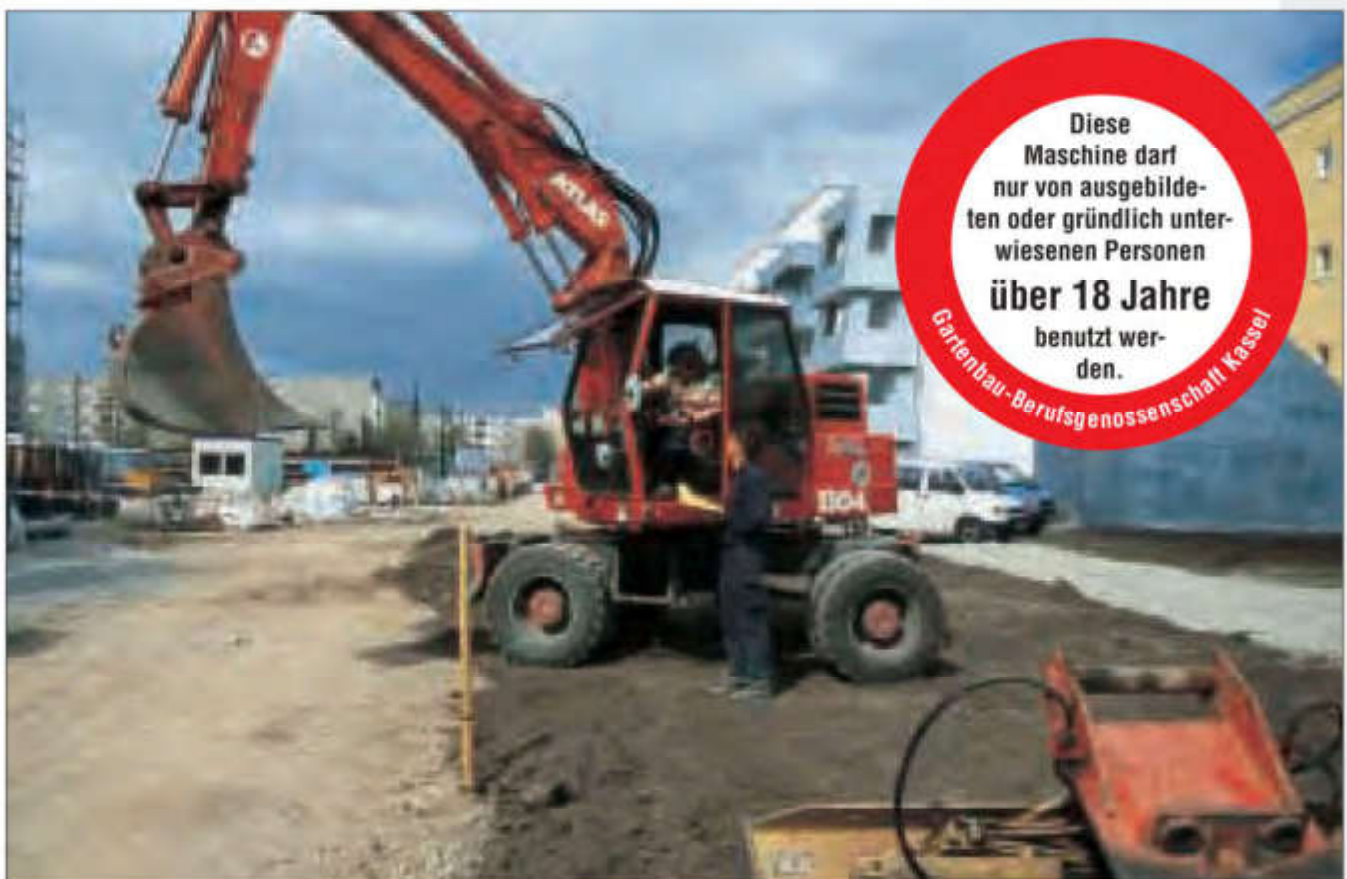
Unterweisung auf der Baustelle
