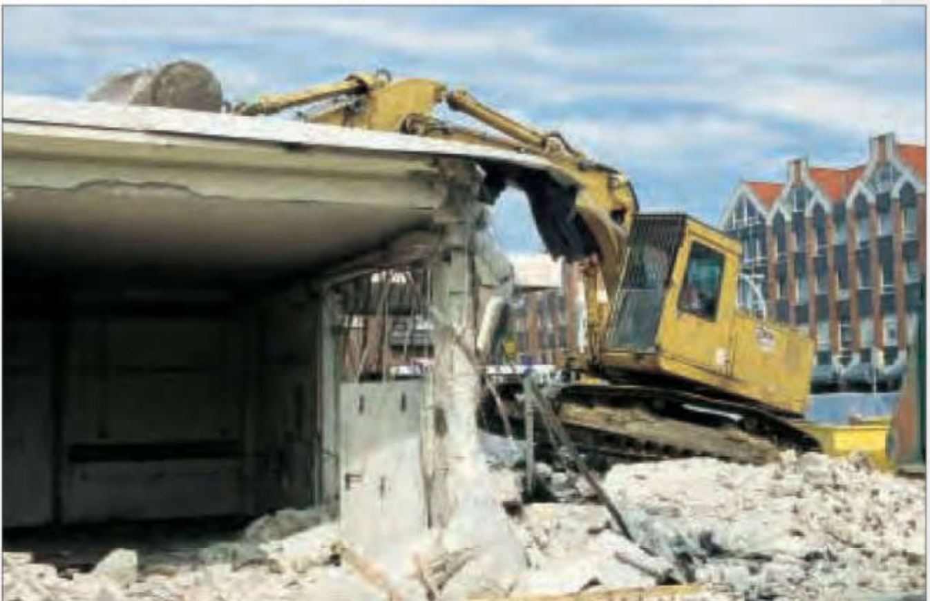
Abbrucharbeiten mit Hydraulikbagger
