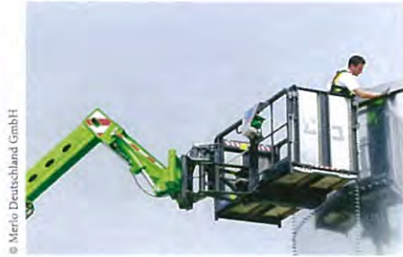
■ Abb. 8.22 Personenbeförderung mit Arbeitsbühne
